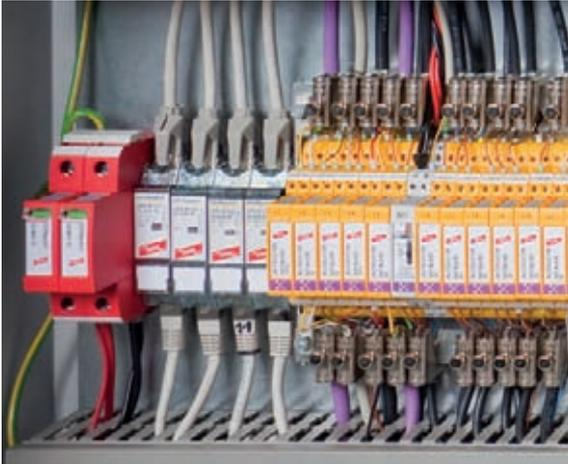
Figura 9.16.11 Esempio di i dispositivi di protezione contro le sovratensioni in un sistema di regolazione del passo
