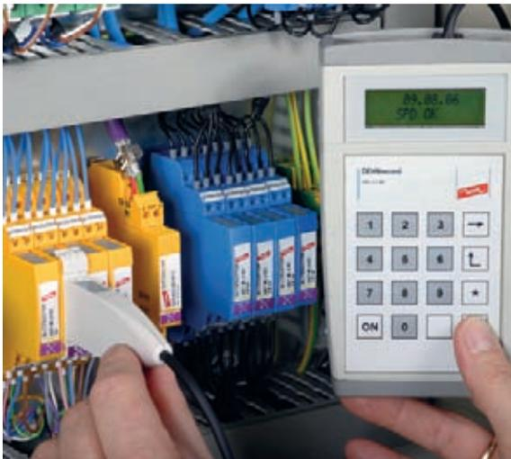
Figura 9.3.12 Moduli scaricatore combinato con LifeCheck
