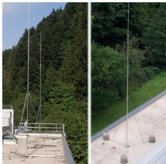
Figura 5.1.11.1 Protezione dalle scariche dirette con aste indipendenti
