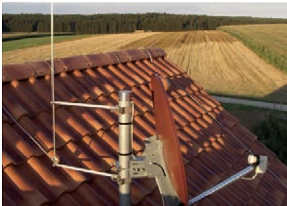
Figura 5.1.2.5 Antenna con asta di captazione isolata.
