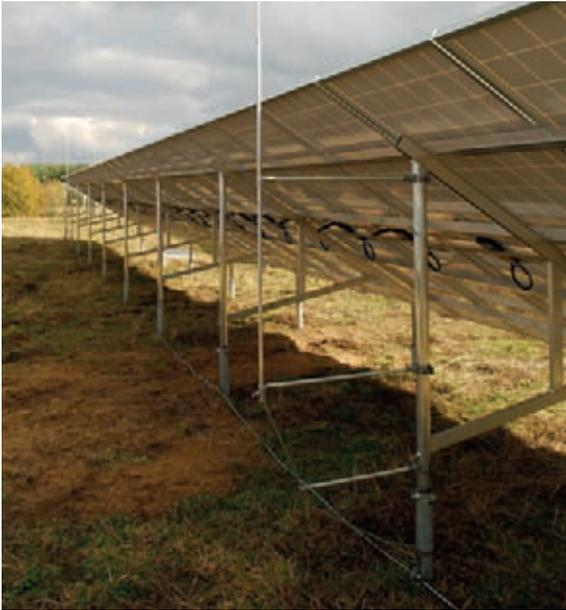
Figura 9.19.2 Protezione contro i fulmini mediante distanziatori DEHNiso
