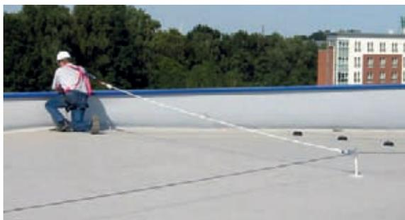
Figura 5.1.12.1 Cavo di sicurezza su un tetto piano
