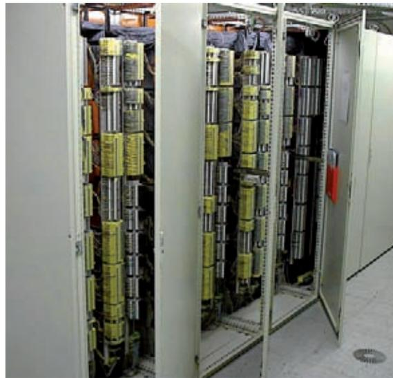
Figura 9.4.6 Morsetteria DEHNconnect con dispositivo di protezione da sovratensioni integrato per la protezione dell'intero sistema CMR
