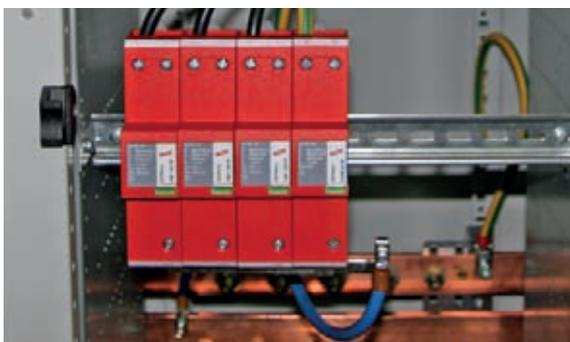
Figura 9.16.8 Limitatore di sovratensione coordinato Tipo 1
