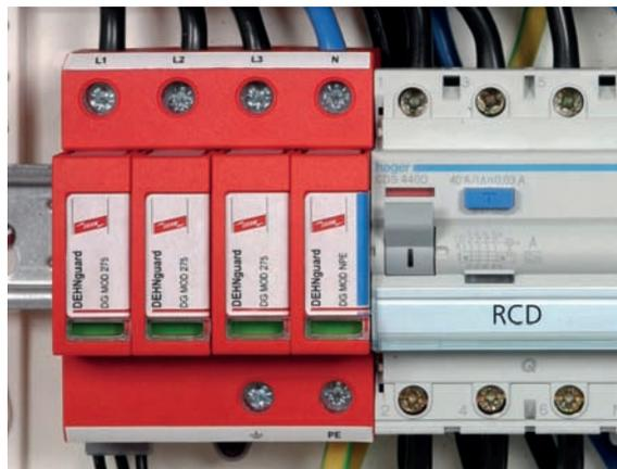
Figura 7.8.1.2 Limitatore di sovratensione multipolare DEHNguard M TT
