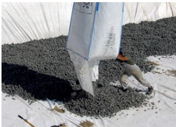
Figura 5.5.2.23 Isolamento perimetrale: riempimento con fibra di vetro granulare. Fonte: TECHNOpor Handels GmbH
