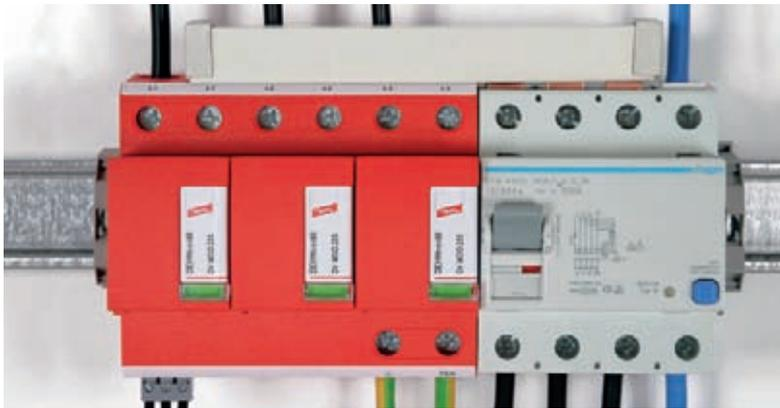
Figura 8.1.6.11 Cablaggio a V dello scaricatore combinato DEHNventil MTNC tramite sbarra collettice
