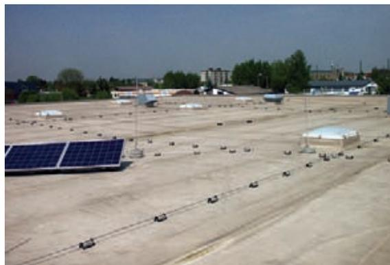
Figura 5.1.3.2 Applicazione pratica delle aste di captazione
