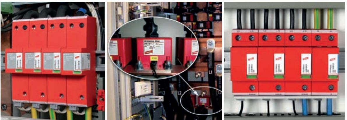
Figura 7.5.2.9 Scaricatori di corrente di fulmine nel passaggio da LPZ 0<sub>A</sub> a LPZ 1
