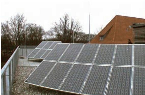
Figura 5.1.8.6 Sistema di captazione isolato per l'impianto fotovoltaico
