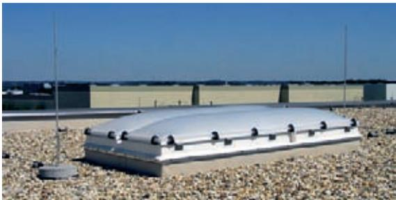
Figura 5.1.1.17 Protezione di piccole strutture sul tetto da fulminazione diretta con aste di captazione
