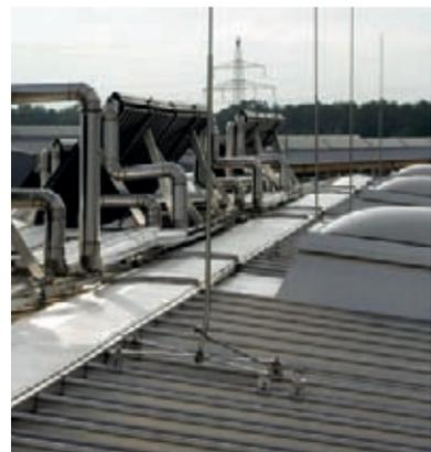
Figura 5.1.4.7 Asta di captazione per lucernari su copertura con ribordatura tonda
