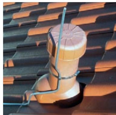
Figura 5.1.2.3 Dispositivo di captazione supplementare per tubi di sfiatione
