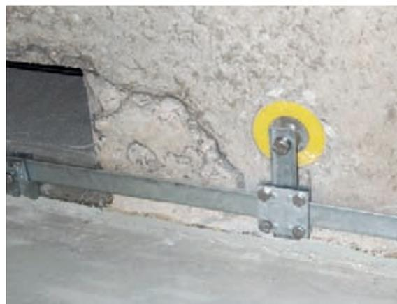
Figura 7.7.1.1 Collettore equipotenziale ad anello e dispersore fisso per la connessione di installazioni metalliche
