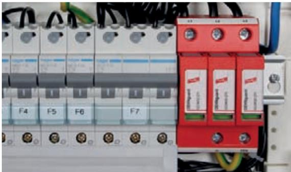
Figura 9.16.6 Scaricatore modulare Tipo 2 per la protezione di linee a 230/400 V
