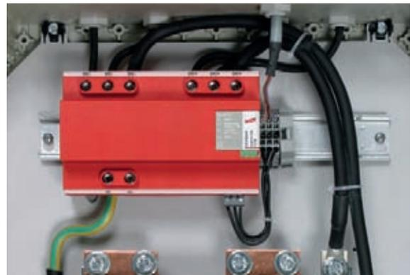
Figura 9.18.8 Scaricatore spinterometrico combinato Tipo 1 DEHN Nimit PV 1000 V2
