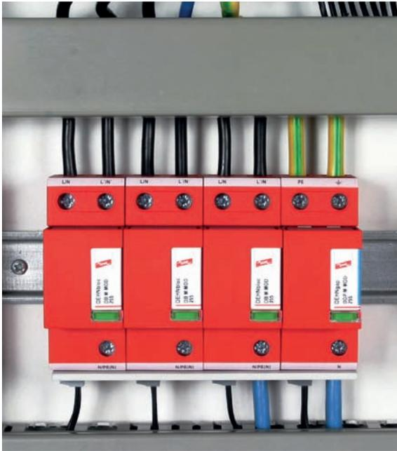
Figura 6.2.1 DEHNbloc M per installazione conforme al concetto di zona di protezione contro i fulmini al confine  $0_A-1$
