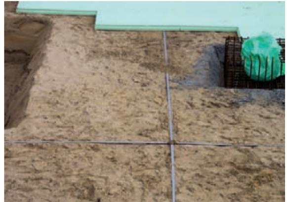
Figura 5.5.2.21 Dettaglio di un dispensore ad anello. Fonte: Ditta Mauermann
