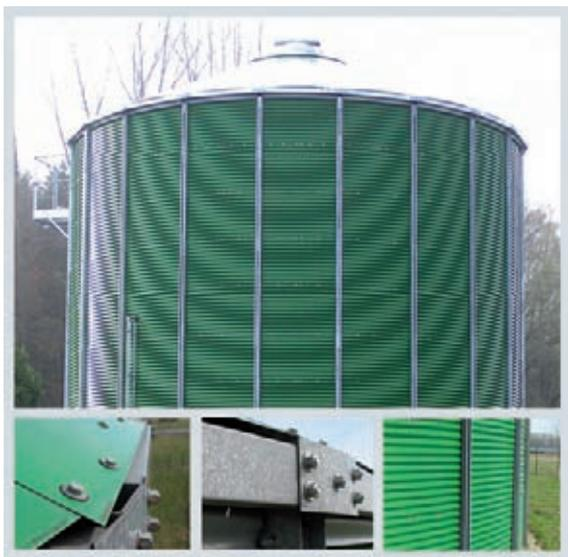
Figura 9.3.6 Fermentatore realizzato con lastre metalliche avvitate
