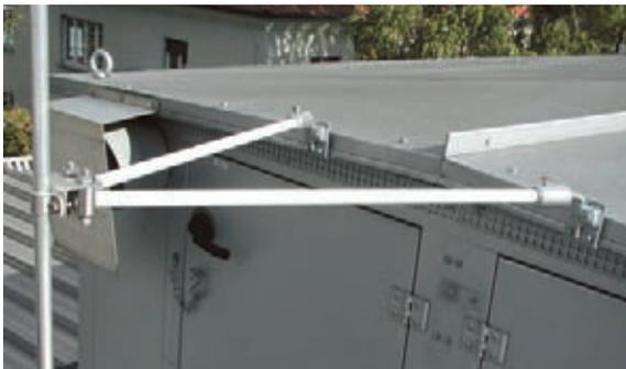
Figura 5.1.8.4 Sostegno angolare dell'asta di captazione
