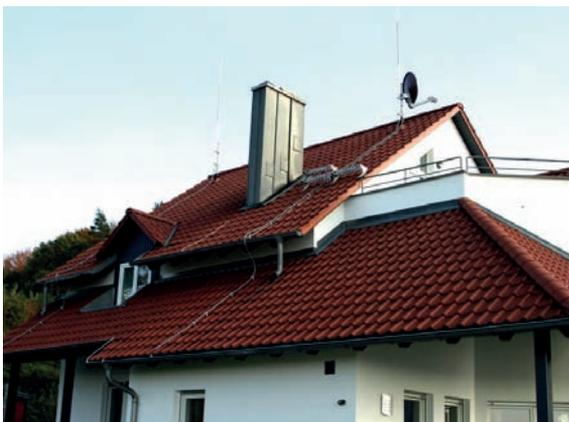
Figura 5.2.4.7 Protezione di un edificio residenziale con conduttura DEHNcon-H (conduttura HVI leggera I)
