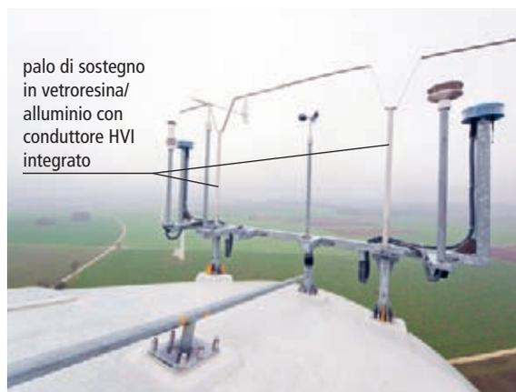
Figura 9.16.2 Esempio di un impianto di messa a terra per stazione meteo e luce di segnalazione ostacoli al volo
