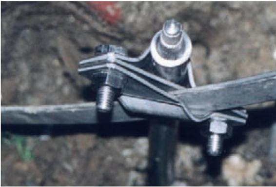
Figura 5.9.4 Collegamento di un dispersore all'anello dei dispersori della cabina
