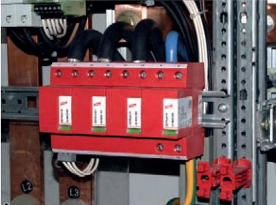
Figura 9.22.2 Equipotenzialità antifulmine con DEHNventil M
