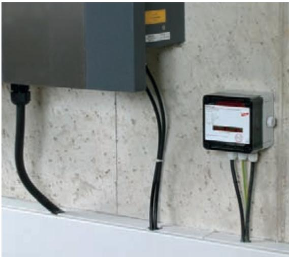
Figura 9.18.16 Scaricatore DEHNcube YPV SCI 1000 1M Tipo 2 per proteggere gli invertitori (1 MPPT)
