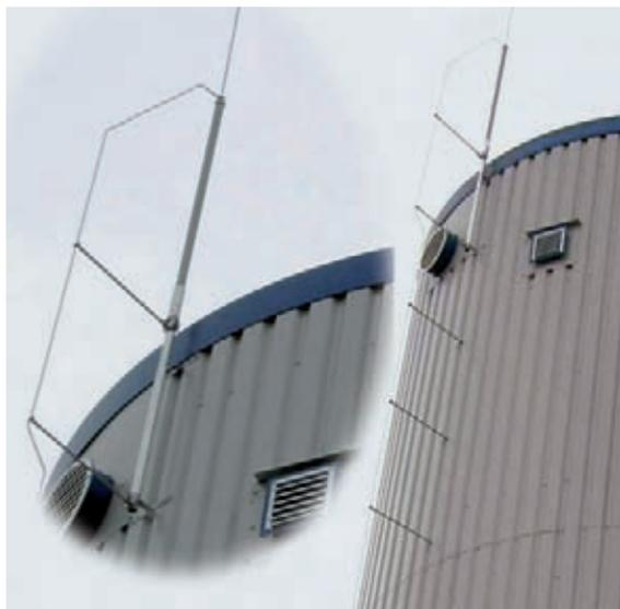
Figura 9.3.7 Protezione del fermentatore in lastre metalliche con dispositivo di captazione isolato (Fonte: Büro für Technik, Hösbach)
