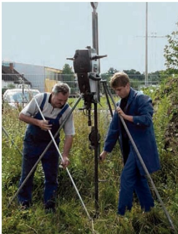
Figura 5.5.4.2 Installazione del dispersore di profondità con supporto e martello vibratore
