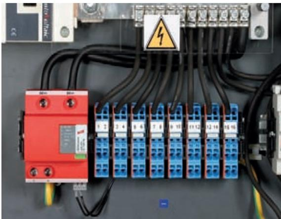
Figura 9.19.11 Dispositivo di protezione contro le sovratensioni nella scatola di derivazione per il monitoraggio di un generatore
