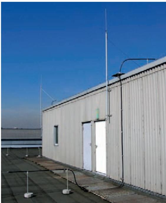
Figura 5.2.4.9 Posa di una condotta HVI III con terminale
