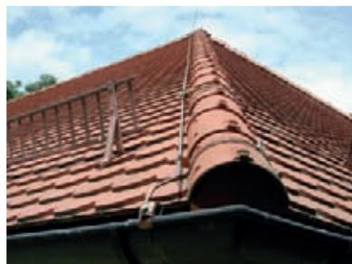
Figura 5.2.2.1.3 Organo di captazione con collegamento alla grondaia
