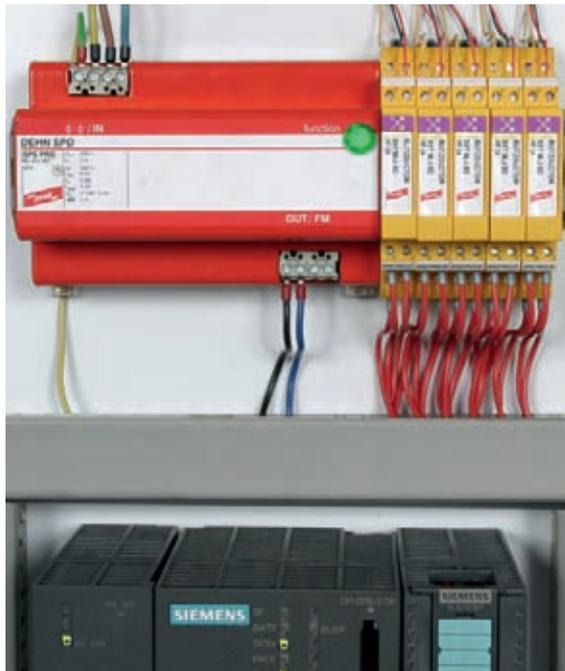
Figura 7.7.3.1 Protezione per utilizzatori elettronici industriali (p.es. un PLC) con BLITZDUCTOR XT e SPS-Protector
