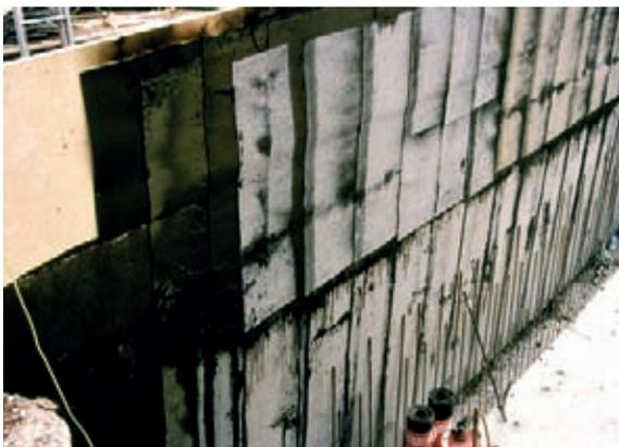
Figura 5.5.2.18 Rivestimento impermeabile con fogli bituminosi
