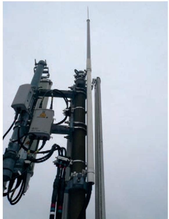
Figura 5.2.4.14 Conduittura HVI installata su un traliccio radio
