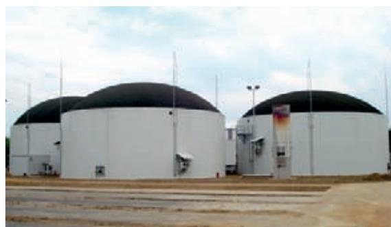
Figura 5.2.4.18 Protezione di un fermentatore a biogas con un conduttura HVI I
