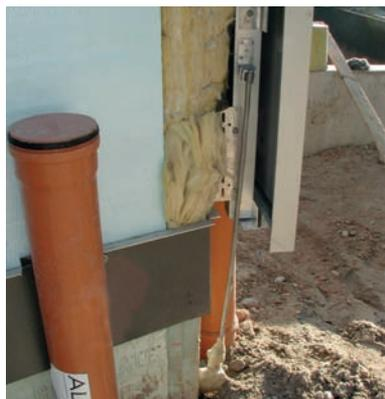
Figura 5.2.2.2.3 Collegamento a terra della facciata metallica
