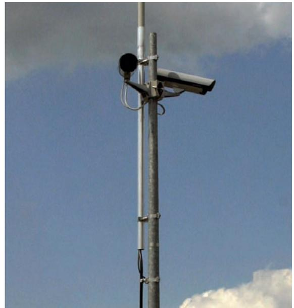
Figura 9.22.4 Conduttore HVI installato in una torre
