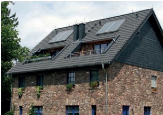
Figura 5.1.2.4 Edificio con impianto fotovoltaico e distanza di isolamento sufficiente. Fonte: Blitzschutz Wettingfeld, Krefeld, Germania
