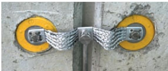
Figura 5.5.2.8 Treccia di collegamento con dispersori fissi
