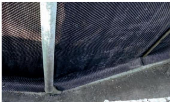
Figura 5.5.2.11 Uso delle membrane bugnate
