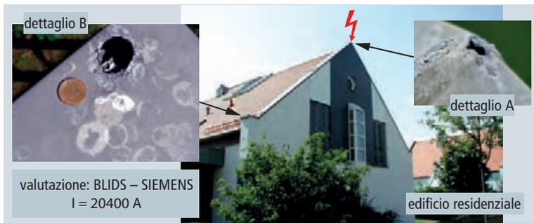
Figura 5.1.4.2 Esempio di danno su copertura in lamiera
