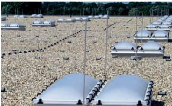
Figura 5.1.1.19 Tetto piano con aste di captazione e staffe portafilo: protezione per lucernari
