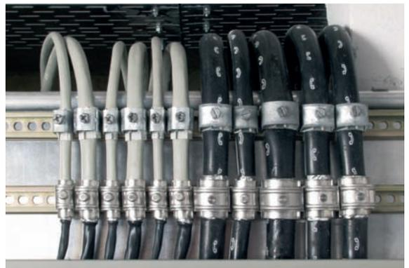
Figura 6.3.4 Sistema di collegamento di una schermatura che conduce la corrente di fulmine (SAK)
