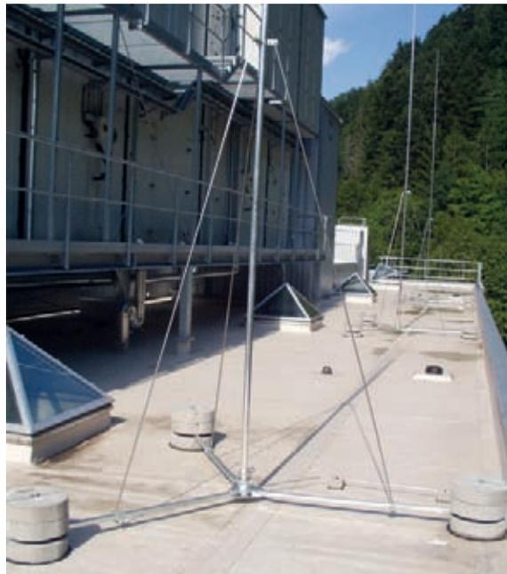
Figura 5.1.8.7 Impianto di captazione isolato per strutture sul tetto
