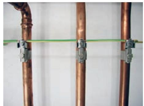
Figura 6.1.6 Barra di collegamento equipotenziale con cablaggio passante
