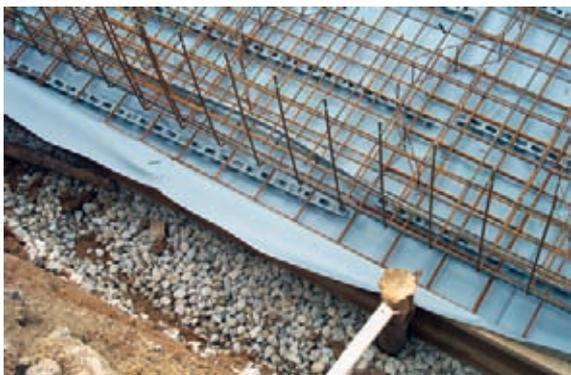
Figura 5.5.2.10 Membrana di piastre di fondazione
