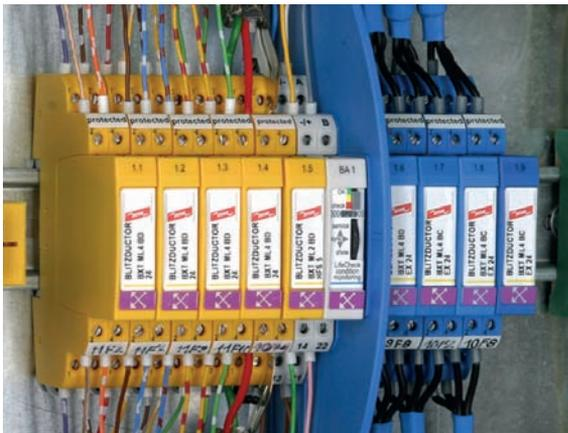
Figura 8.2.6.3 Sorveglianza dei dispositivi di protezione contro le sovratensioni per mezzo di il DRC MCM XT condizione unità di monitoraggio
