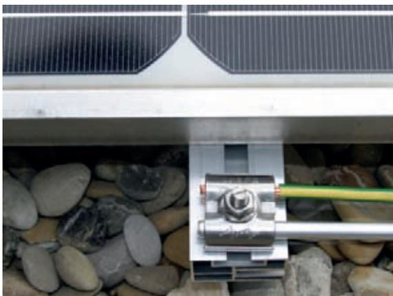
Figura 9.18.3 Morsetto di messa a terra UNI: un elemento intermedio in acciaio inossidabile impedisce la corrosione di contatto, stabilendo così dei collegamenti affidabili a lungo termine tra i diversi materiali conduttori
