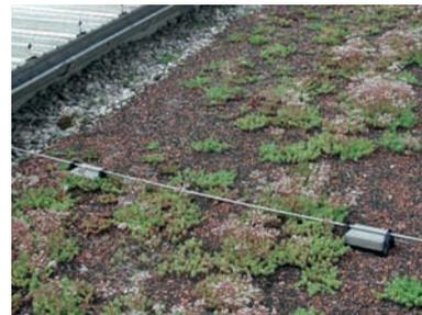
Figura 5.1.7.3 Posa del conduttore sopra il manto di copertura
