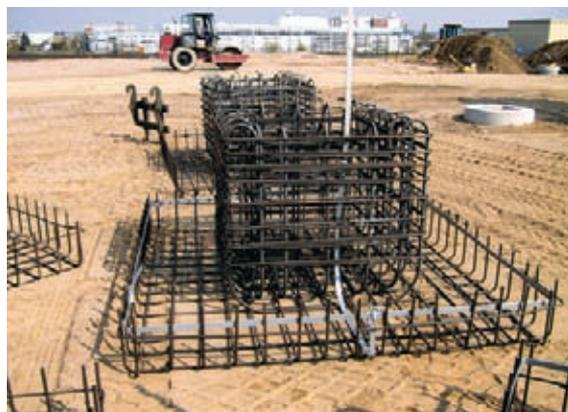
Figura 5.5.2.24 Dispersore di fondazione per plinti con capocorda di collegamento. Fonte: Wettingfeld, Krefeld
