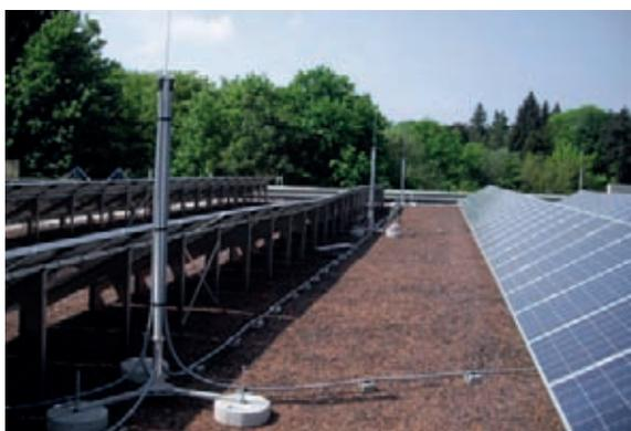
Figura 5.2.4.5 Protezione di un sistema PV con conduttura HVI leggera
