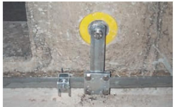
Figura 7.4.3 Collegamento del collettore ad anello al sistema equipotenziale attraverso punto fisso di messa a terra
