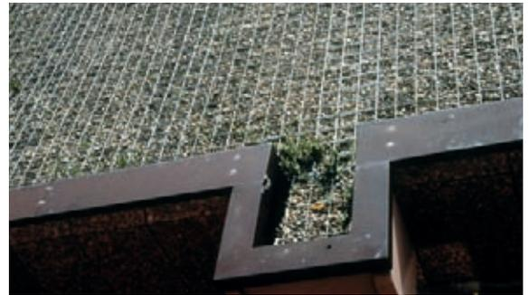
Figura 7.3.7a Reti zincate elettrosaldate per la schermatura dell'edificio
