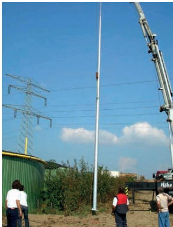
Figura 5.1.8.8 Posizionamento di un palo componibile in acciaio per la protezione contro i fulmini
