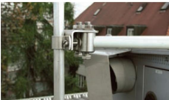
Figura 5.1.8.5 Fissaggio dell'asta di captazione
