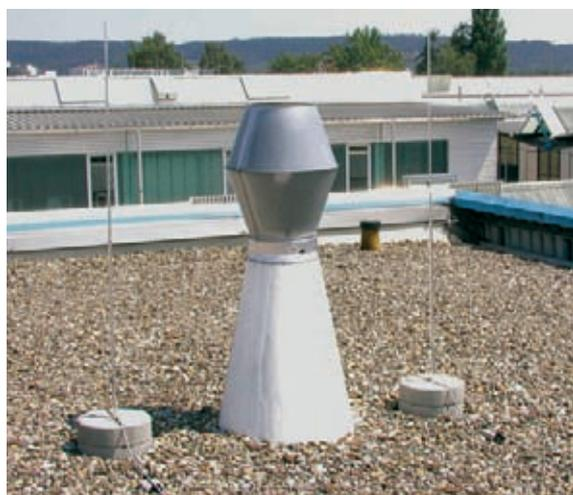
Figura 5.1.8.2 Impianto di captazione isolato – Protezione mediante asta di captazione
