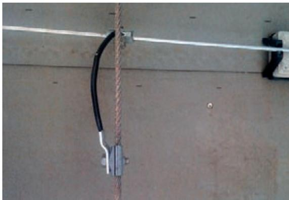
Figura 5.1.12.2 Installazione non corretta: il cavo di sicurezza interseca i captatori
