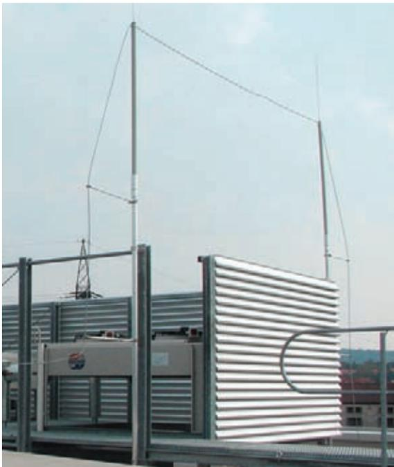
Figura 5.1.8.13 Dispositivo di captazione isolato con DEHNiso Combi
