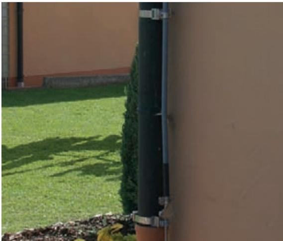
Figura 5.2.4.6 Collegamento di una conduttura DEHNcon-H (conduttura HVI leggera I) all'impianto di messa a terra
