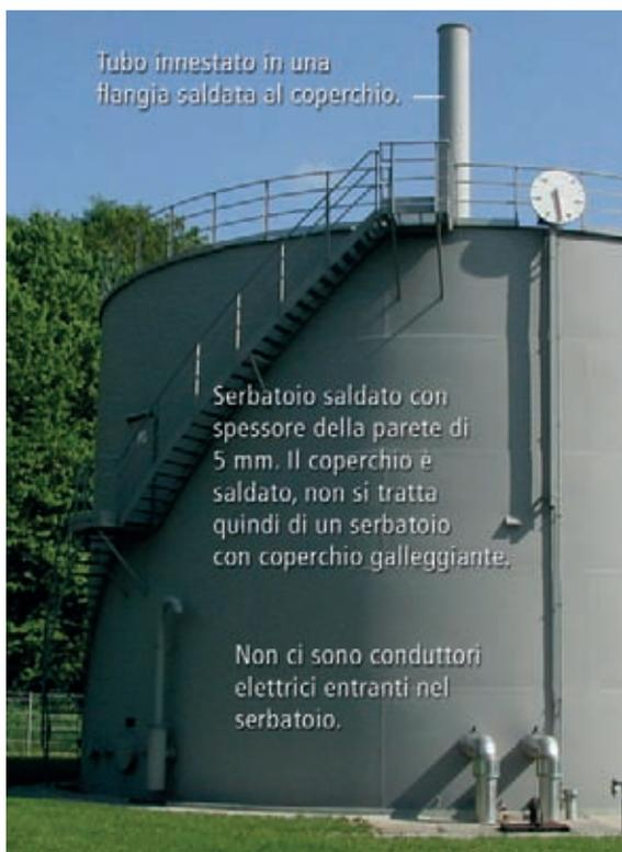
Figura 9.3.8 Serbatoio in acciaio saldato (Fonte: Eisenbau Heilbronn GmbH)
