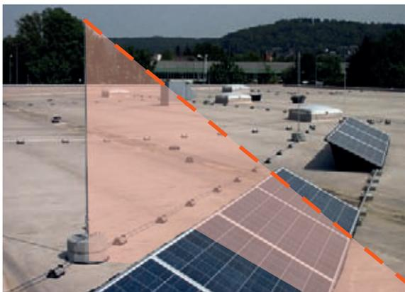
Figura 9.18.14 Determinazione del volume protetto utilizzando il metodo dell'angolo di protezione
