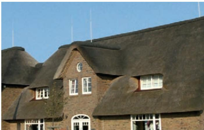
Figura 5.1.5.4 Fattoria storica con impianto di protezione esterno
