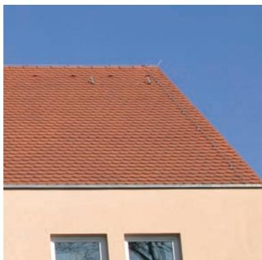
Figura 5.1.2.1 Dispositivo di captazione su tetto a doppio spiovente
