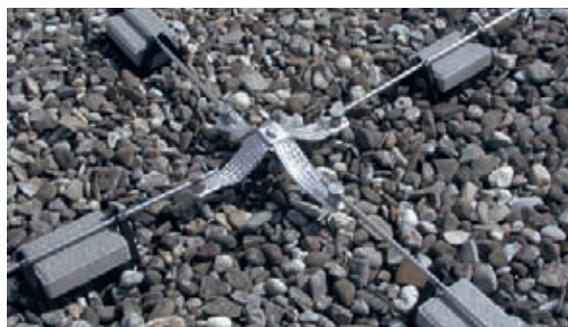
Figura 5.4.1.1 Dispositivo di captazione - Compensazione della dilatazione con trecce di collegamento
