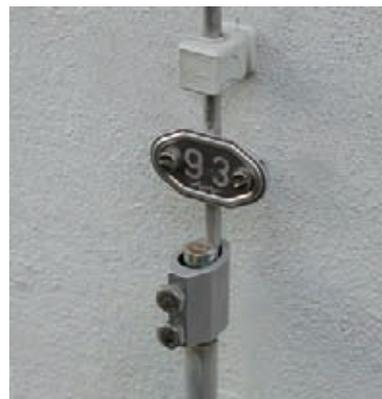
Figura 5.2.2.3.1 Punto di sezionamento con numero di identificazione
