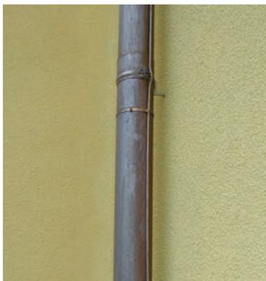
Figura 5.2.2.2.4 Calata lungo il pluviale
