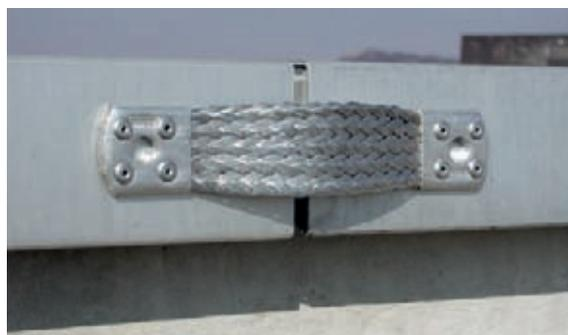
Figura 5.1.3.3 Treccia di collegamento della scossalina
