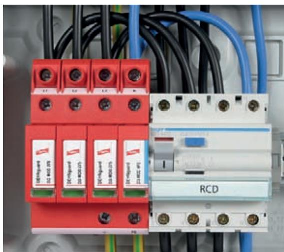
Figura 7.7.2.3 Limitatore di sovratensione multipolare DEHNgard M TT
