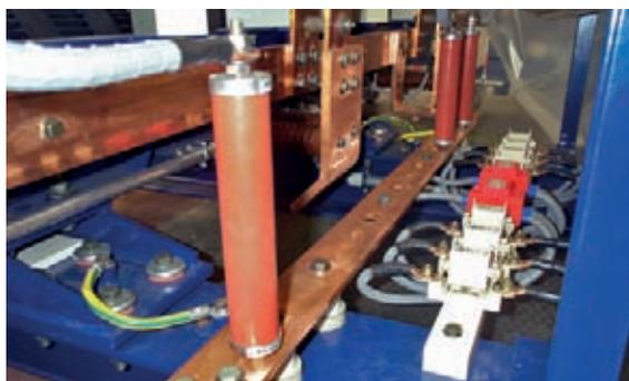
Figura 9.16.9 Scaricatori di media tensione DEHNmid installati in un trasformatore per turbine eoliche
