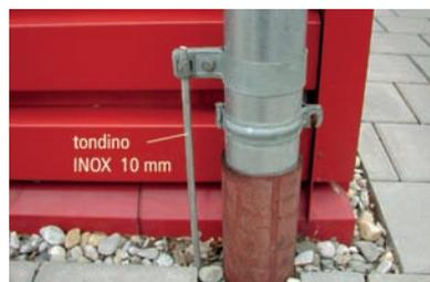
Figura 5.2.2.1.4 Collegamento di terra di una calata
