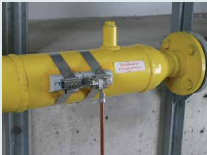
Fascetta per tubi per il contatto elettrico di tubazioni in ambiente Ex, per la realizzazione dell'equipotenzializzazione antifulmine secondo CEI EN 62305-3 (CEI 81-10/3)
