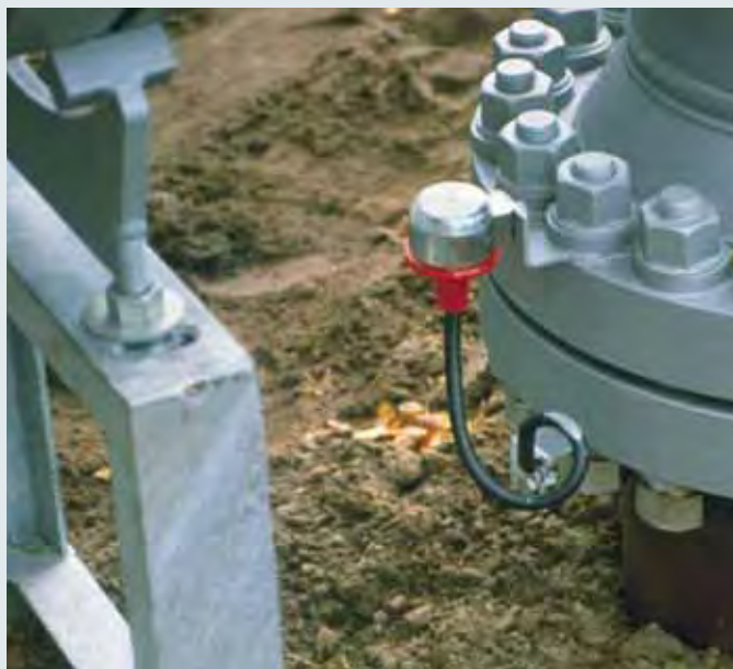
Spinterometri certificati ATEX, per l'equipotenzializzazione antifulmine secondo CEI EN 62305-1, in esecuzione sperimentata con connessione in cavo flessibile.
