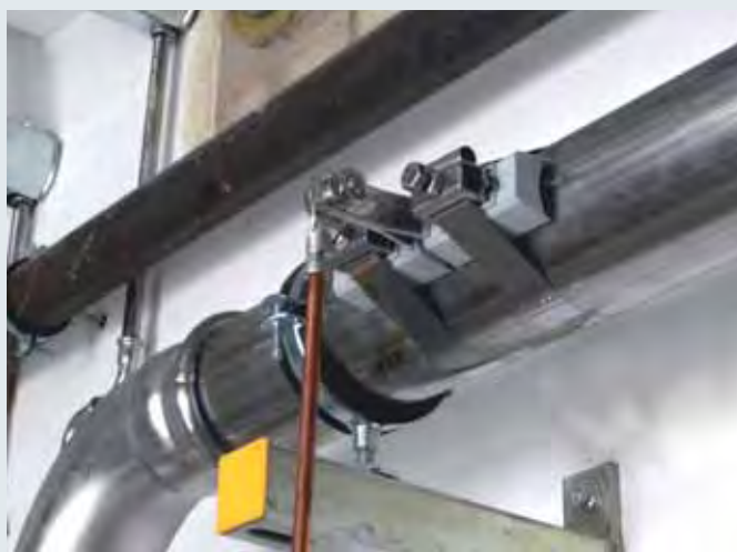
Applicazione su una tubazione in acciaio inossidabile
