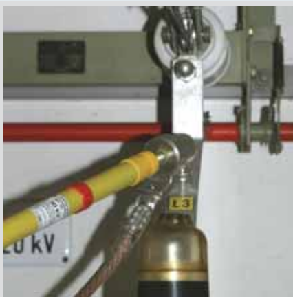
Fioretto isolante IS SK per la manovra di morsetti dei dispositivi di messa a terra ed in corto circuito con codolo ad esagono.
