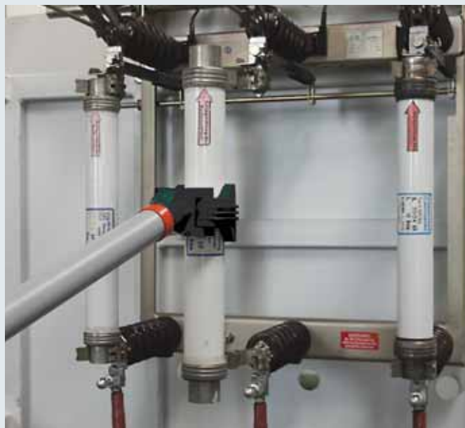
Pinza per fusibili SZ inclinata a 20° per l'inserzione ed estrazione di fusibili HH.
