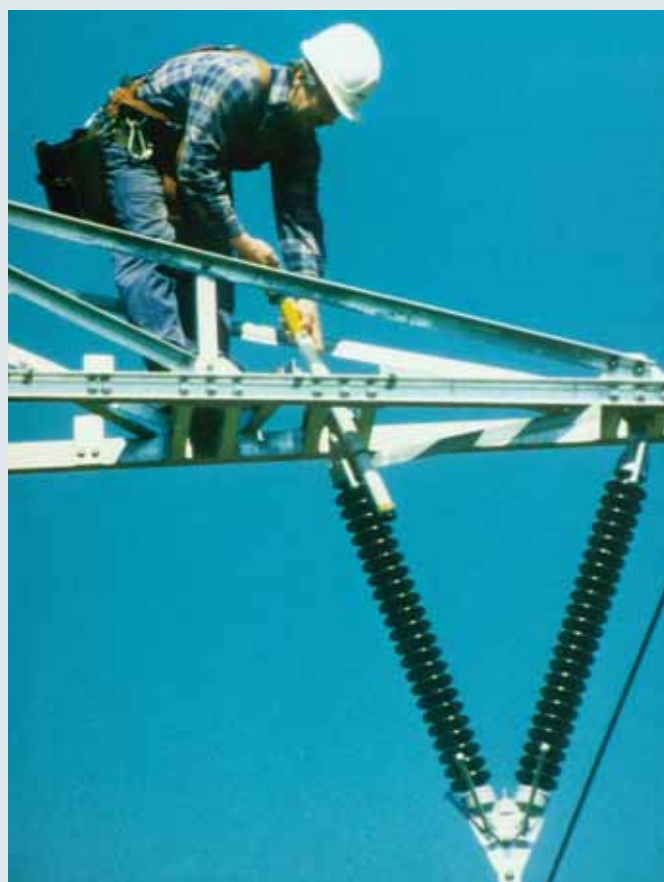
Rivelatore di tensione a distanza su una linea aerea di 110 kV.
