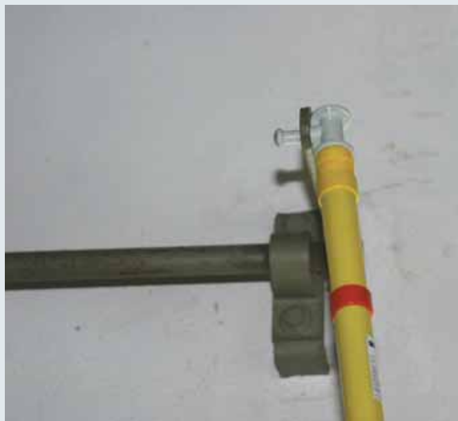
Gancio di manovra avvitabile su fioretto isolante IS SK per la commutazione di un sezionatore sotto carico.
