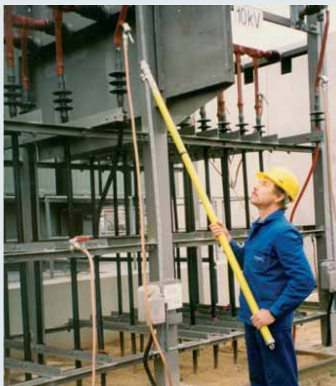
Pinza per punti fissi a sfera rigida con codolo filettato lungo e fioretto di messa a terra.
